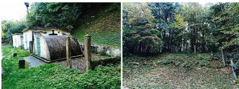
Protection du périmètre immédiat inexistante
