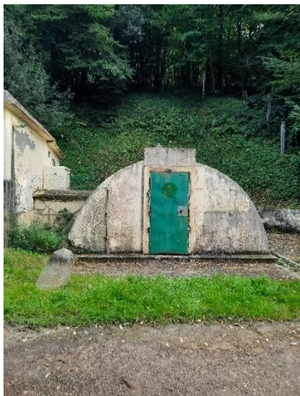
Chambre de captage
